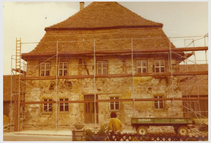
Verfaulte Fachwerk-Balken waren durch Vormauern von schmalen Ziegelsteinen ausgebessert. Ehemaliges großes Haustor sichtbar
