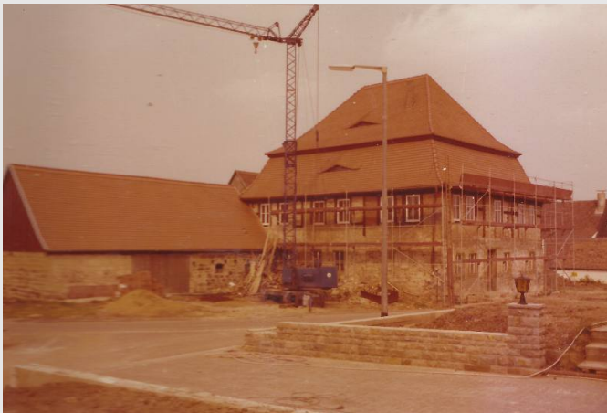
Mit neuem Dach – Juli 1975 / alle Teile originalgetreu nachgebaut
