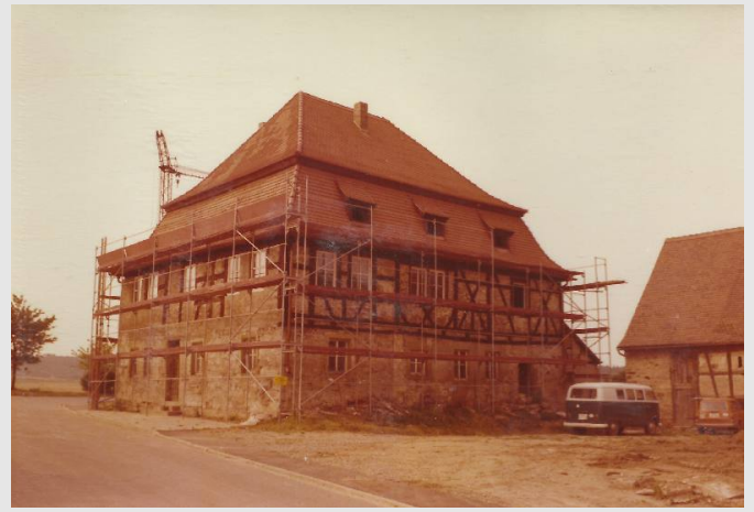
Verfaulte Fachwerk-Balken waren durch Vormauern von schmalen Ziegelsteinen ausgebessert. Ehemaliges großes Haustor sichtbar
